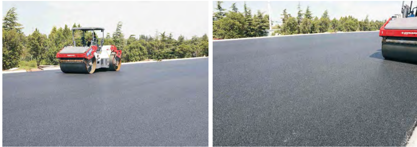
济青高速“四改八”四标摊铺压实效果
