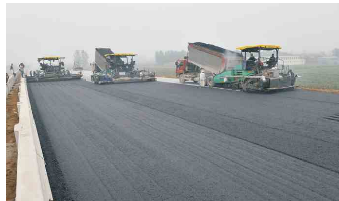
多机并铺的摊铺工艺
