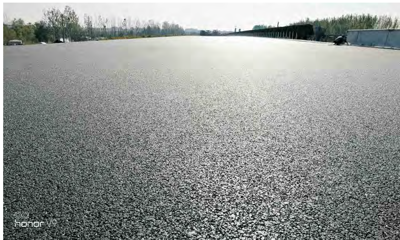
济青高速“四改八”一标摊铺质量 阳光下的济青“四改八”路面，酷似一潭静水
