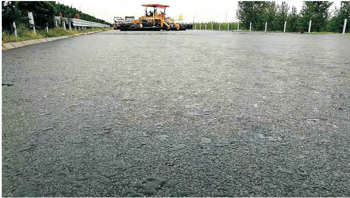
“一字坡”无纵缝整幅摊铺效果展示
