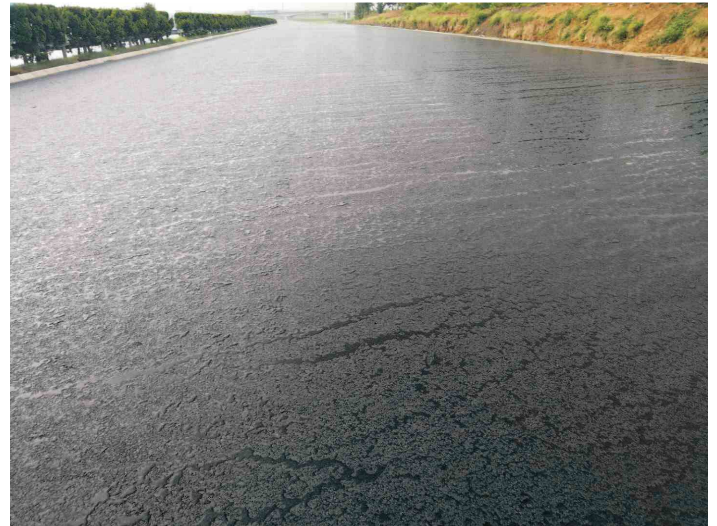
路面验收怕下雨,中大抗离析摊铺机摊铺的路面,平整如水,光洁如镜,均匀如织
