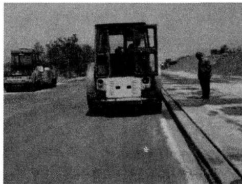
图4 铁三轮对接位置补强碾压
