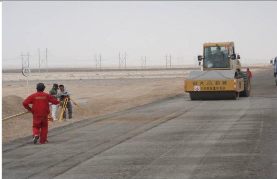
图 压路机碾压过程中基层表面高程的变化监测
