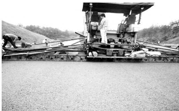
图2 水稳全幅一次摊铺
