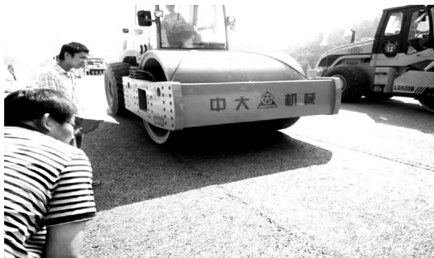
图1 YZ-32中大压路机碾压
